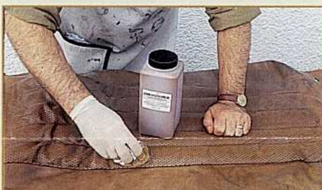
Die erste Grundierung wird von Hand in die Oberfläche eingerieben. Die weiteren Schichten...
