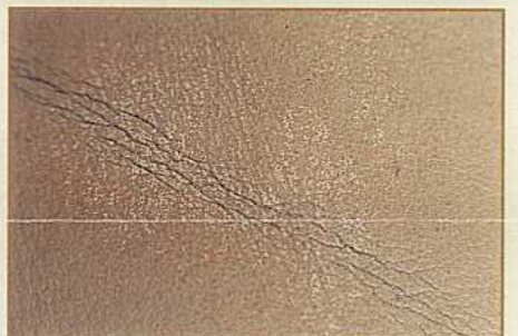
Hier wurde zu kräftig geschauert, die Farbe muss mit einer Tönung unterstützt werden
